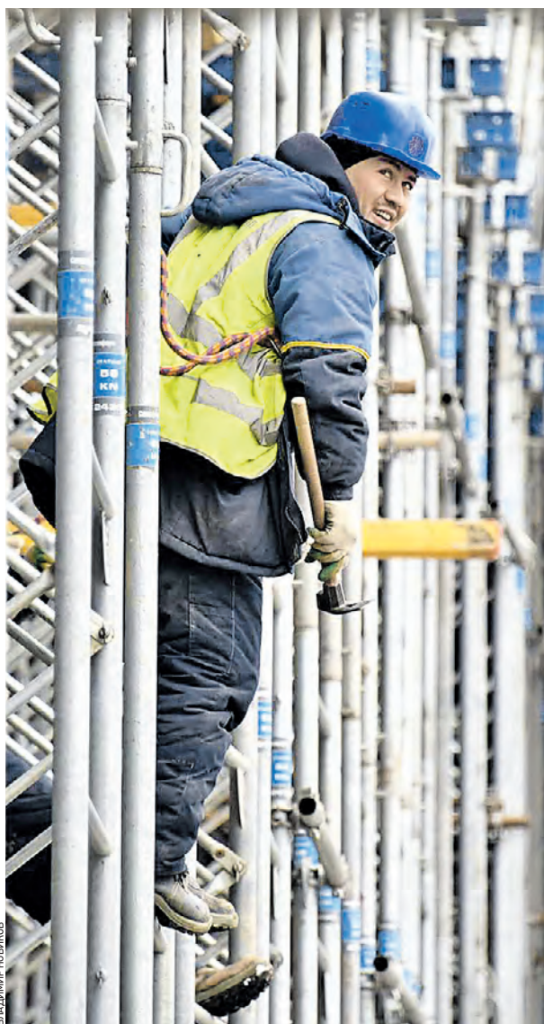
1 апреля 10:35 Эстакада на Волоколамском шоссе. Строители намерены завершить работу ко дню города.
