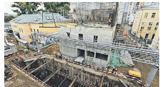
9 сентября 2015 года. Строительная площадка подстанции «Берсеневская»
