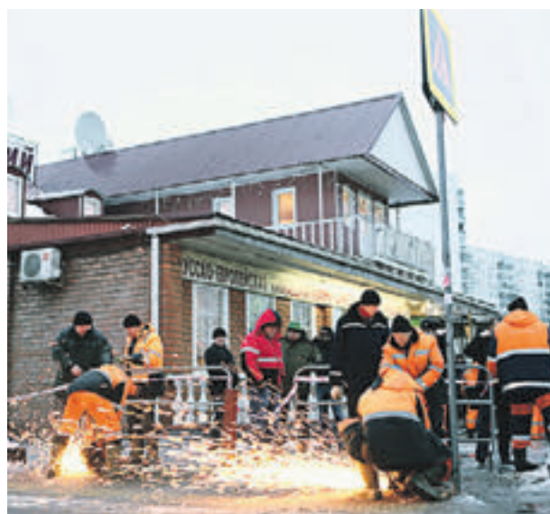
10 декабря 2015 года. Строгинский бульвар. Рабочие уничтожают незаконно возведенный объект
