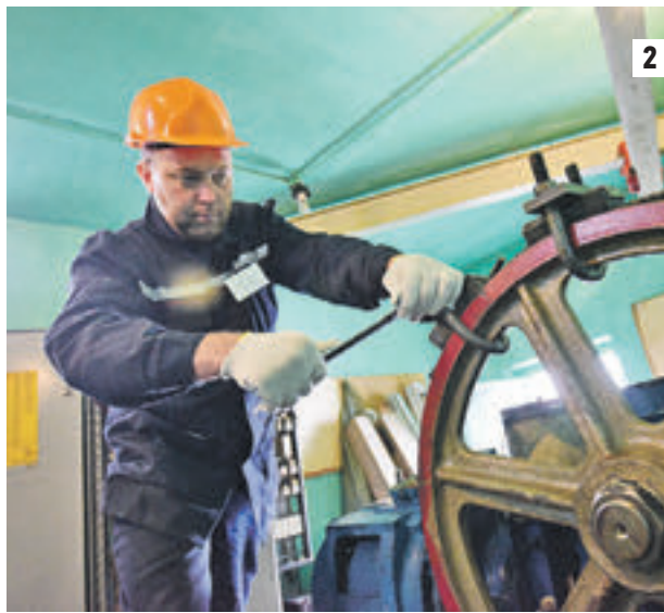
17 августа 2015 года. Работы по замене лифта идут одновременно в шахте и машинном отделении. Всего до конца следующего года предстоит поменять лифты в 1945 жилых домах столицы. Срок работ по каждому лифту — от 45 до 70 дней.
