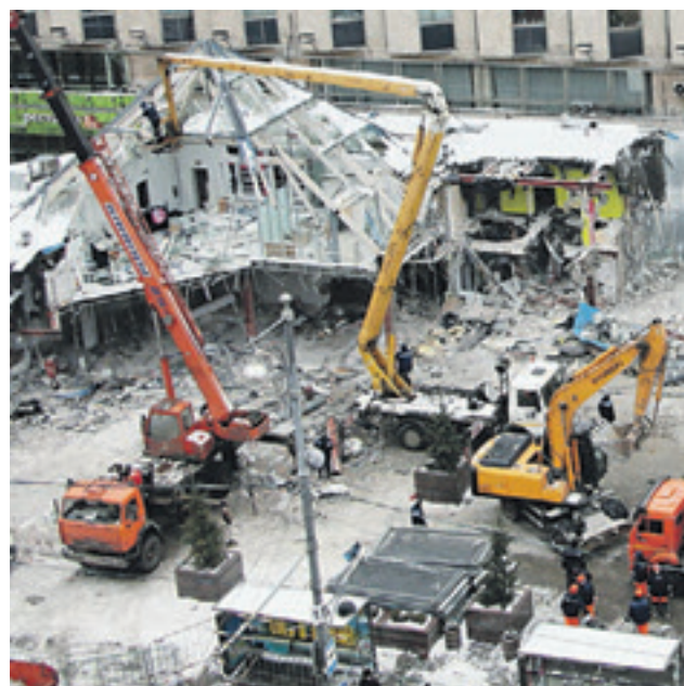
21 февраля 2016 года. Строительные рабочие разбирают конструкции торгового комплекса «Пирамида»
