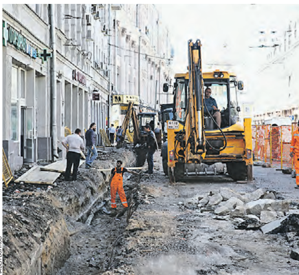
8 июня 2015 года. На Мясницкой началась масштабная реконструкция. Завершится она в августе
