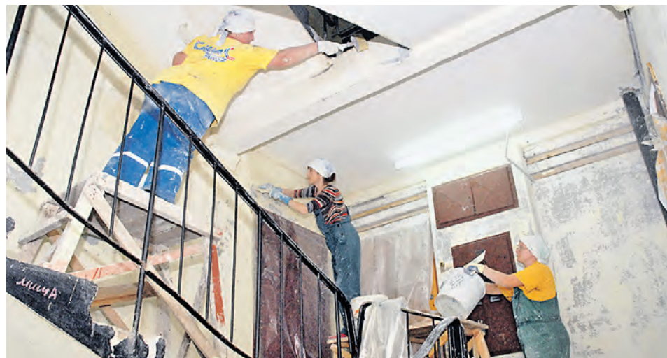
21 мая 2014 года. Проводятся ремонтные работы в доме по Большой Грузинской улице
