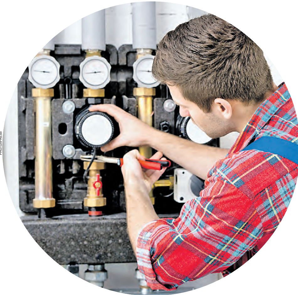
Системы водо- и теплоснабжения многоквартирных домов заменят в ходе проведения капремонта
