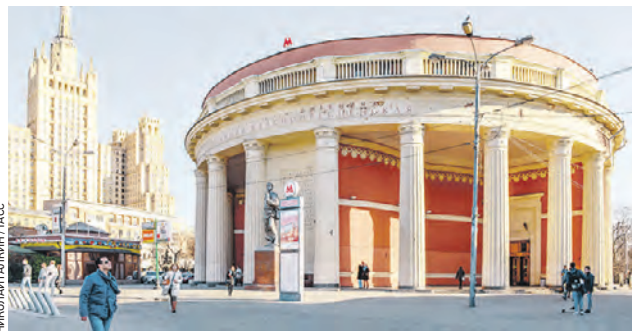
Июнь 2015. К концу года станция метро «Краснопресненская» будет выглядеть по-иному. Наземный вестибюль отреставрируют
