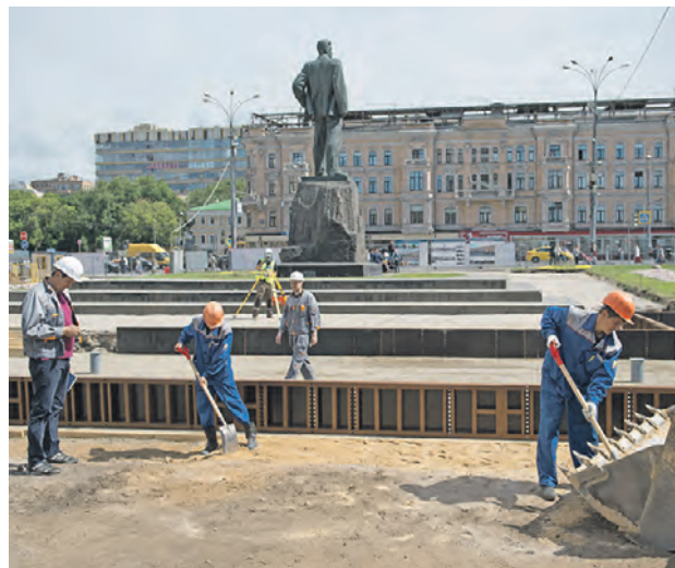
11 июня 2015 года. Реконструкция знаменитого объекта программы — Триумфальной площади — идет полным ходом
