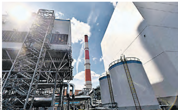
3 17 июня 2015 года. Теплоэлектростанция № 12 обеспечит теплом и электричеством районы центра и запада Москвы
