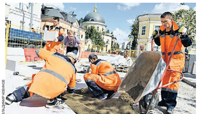
31 июля 2015 года. Реконструкция Большой Ордынки. Рабочие укладывают тротуарную плитку
