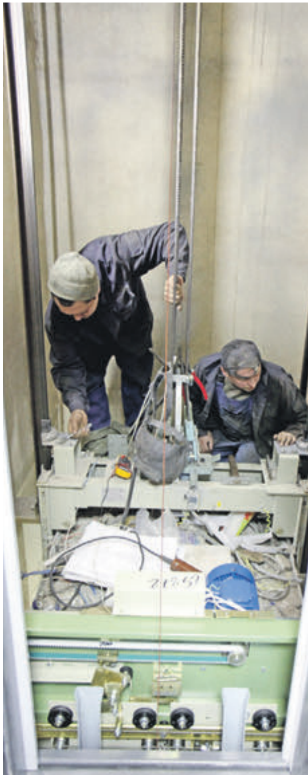
По программе замены лифтов осталось установить около семи тысяч подъемников по всему городу
