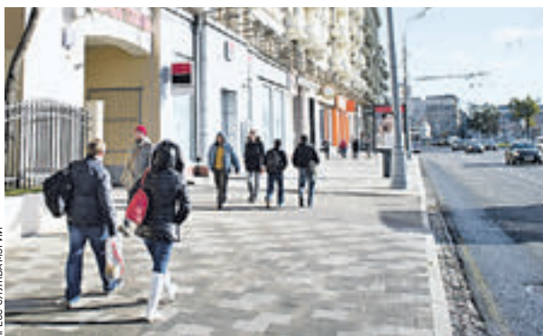
29 октября 2015 года. Москвичи гуляют по отремонтированному Ленинградскому проспекту
