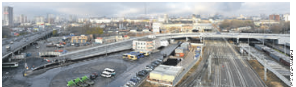
15 сентября 2015 года. Реконструкция Звенигородского путепровода
