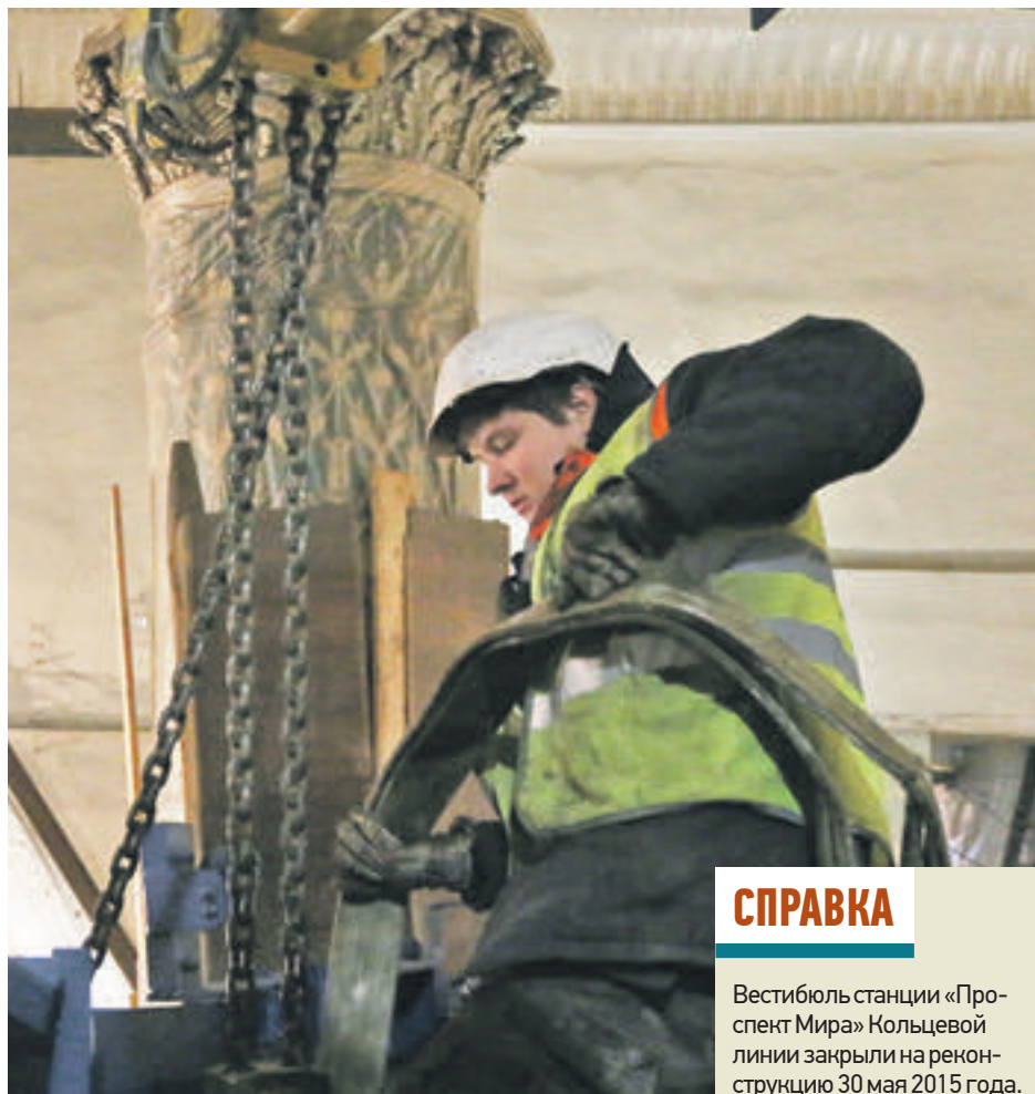
21 января 2015 года. Монтажник Иван Стрекачев устанавливает новые направляющие на подъемник
