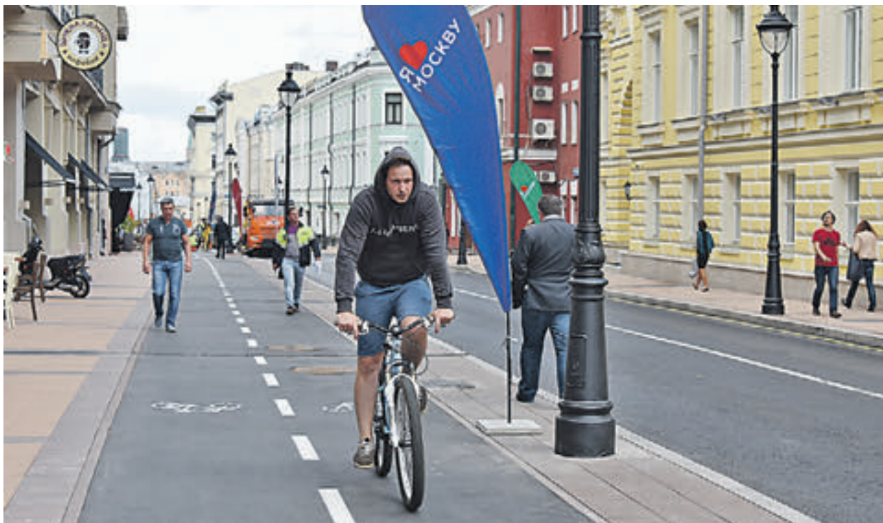
31 августа 2015 года. После завершения реконструкции Большой Никитской улицы здесь стало комфортнее и пешеходам, и велосипедистам, и автолюбителям
