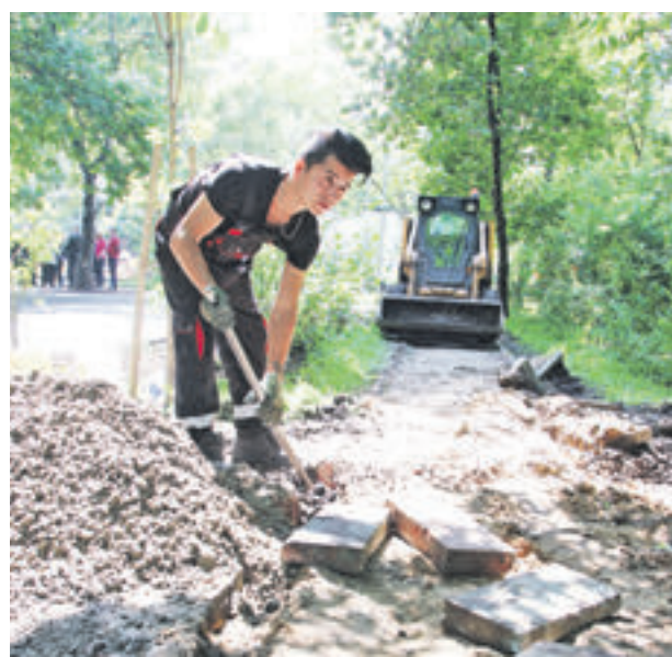
15 июня 2016 года. Рабочий Тимур Очилов устанавливает бордюрный камень вдоль дорожки
