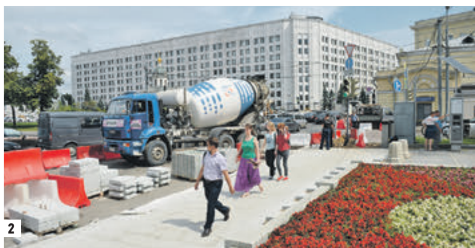
25 июля 2016 года. Довольные москвичи прогуливаются по обновленной Тверской улице (1). 20 июля 2016 года. На Новом Арбате продолжаются работы по благоустройству (2)
