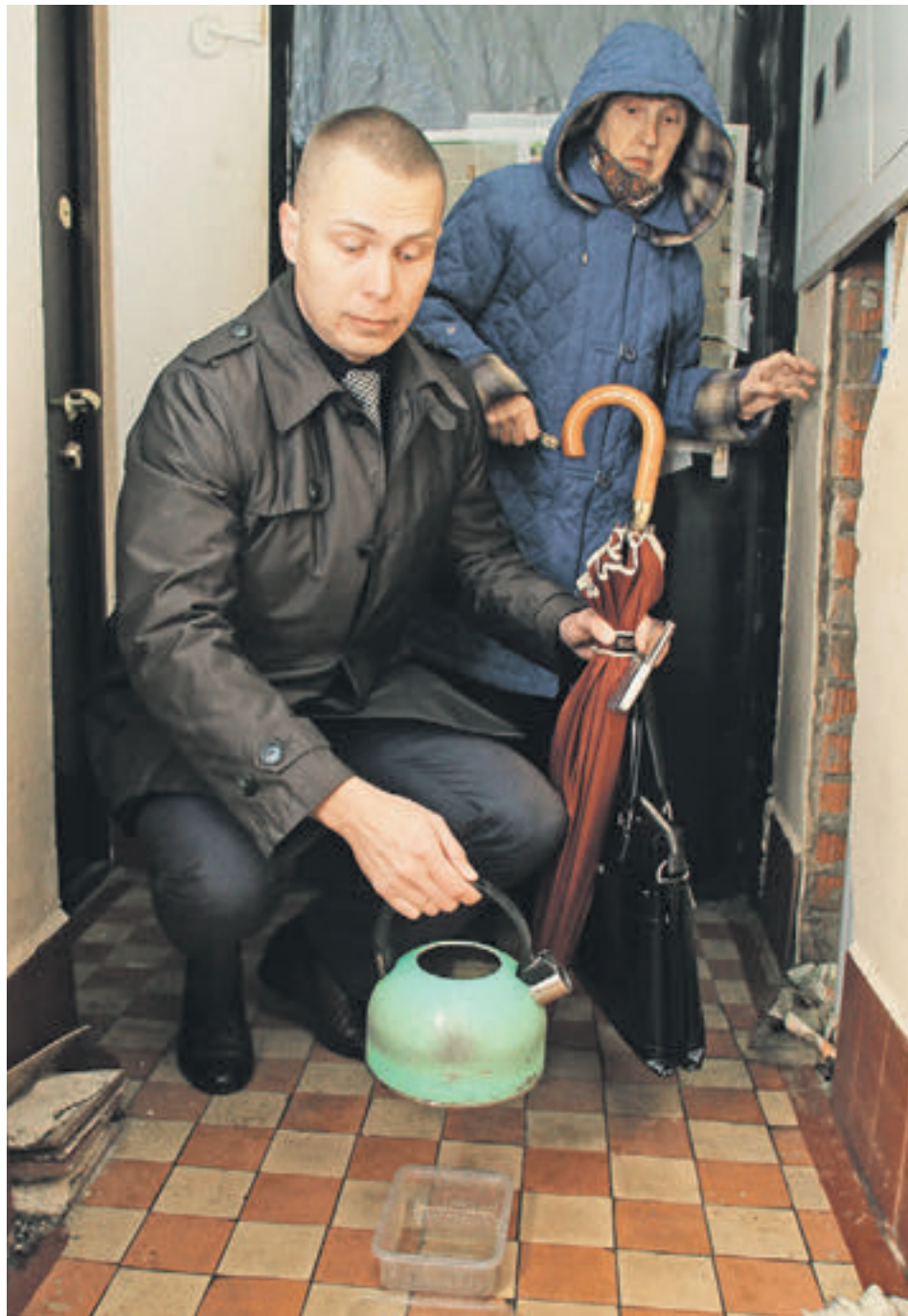
20 сентября 2016 года. Депутат Мещанского района Алексей Бондаренко вместе со старшей по дому Лидией Суворовой осматривает следы от вчерашнего потопы. Накануне здесь прорвало трубу
