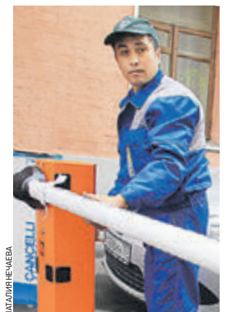
9 октября 2016 года. Рабочий Уринов Хошимжон устанавливает шлагбаум
