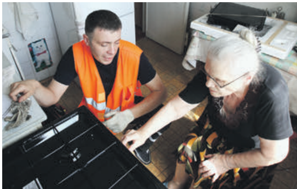
Декабрь 2016 года. Специалист «Мосгаза» производит плановую проверку оборудования в квартире пожилой москвички.
