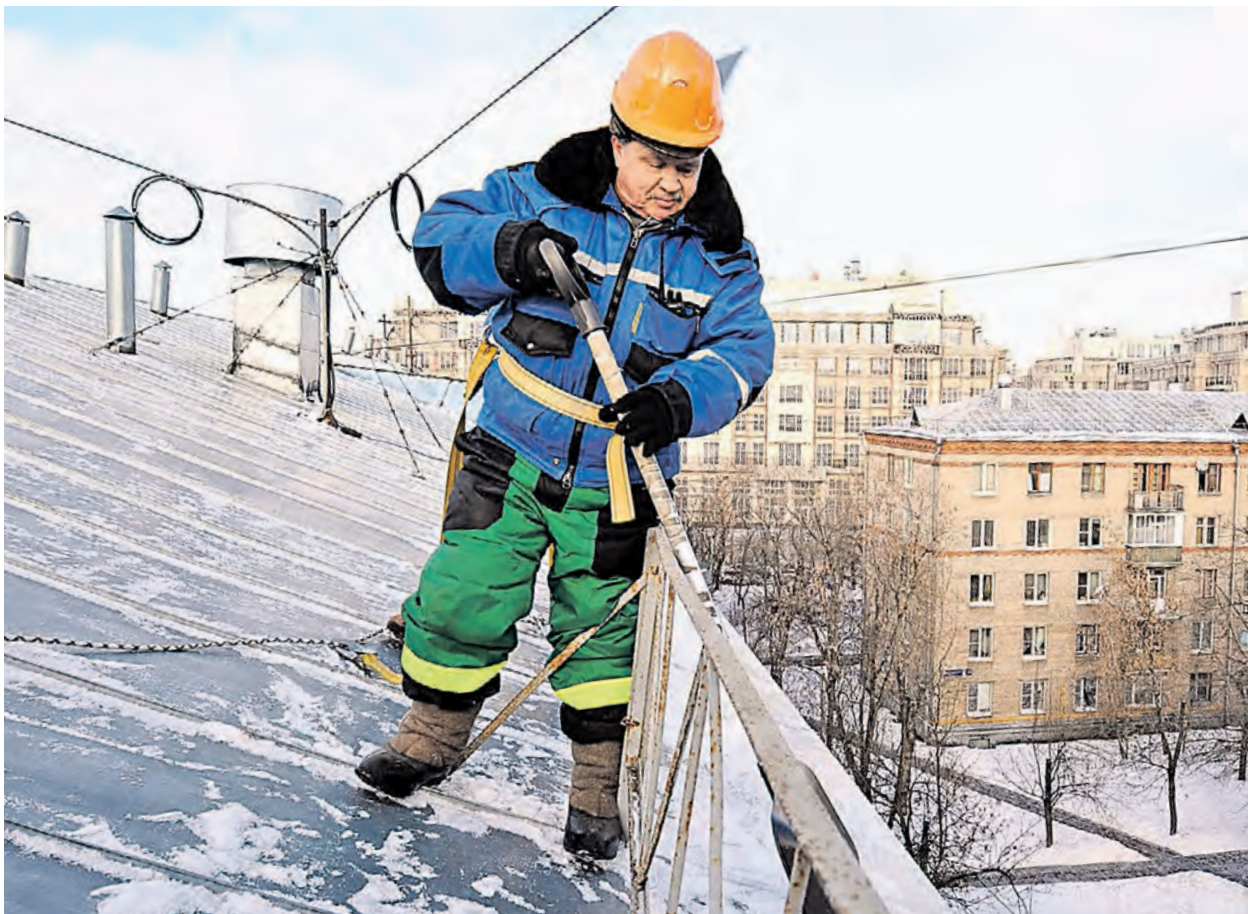
6 февраля 2017 года. Кровельщик ГБУ «Жилищник» района Хамовники Сергей Юрьев очищает козырек крыши дома по адресу: Комсомольский проспект, 46, стр. 1
