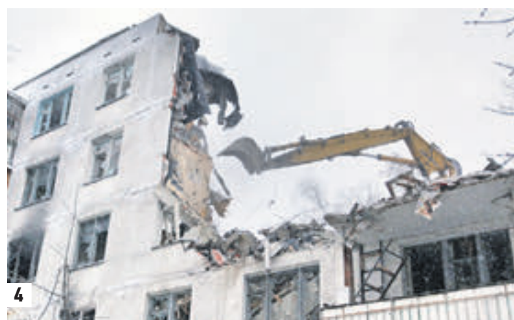
Пятиэтажные жилые дома, подлежащие сносу в СВАО (1). А эти «братья по несчастью» — пятиэтажки, подлежащие сносу в СЗАО (2). Большая Почтовая улица, Буденовский поселок — жилой квартал Москвы, построенный в конце 1920-х годов в стиле конструктивизма по проекту архитектора М. И. Мотылева (3). Снос пятиэтажного дома на улице 13-й Парковой (4)
