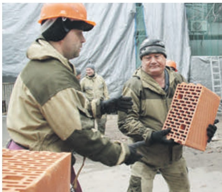
22 марта 2017 года. Лебяжий переулок, 8/4, где идут подготовительные работы к демонтажу незаконной пристройки
