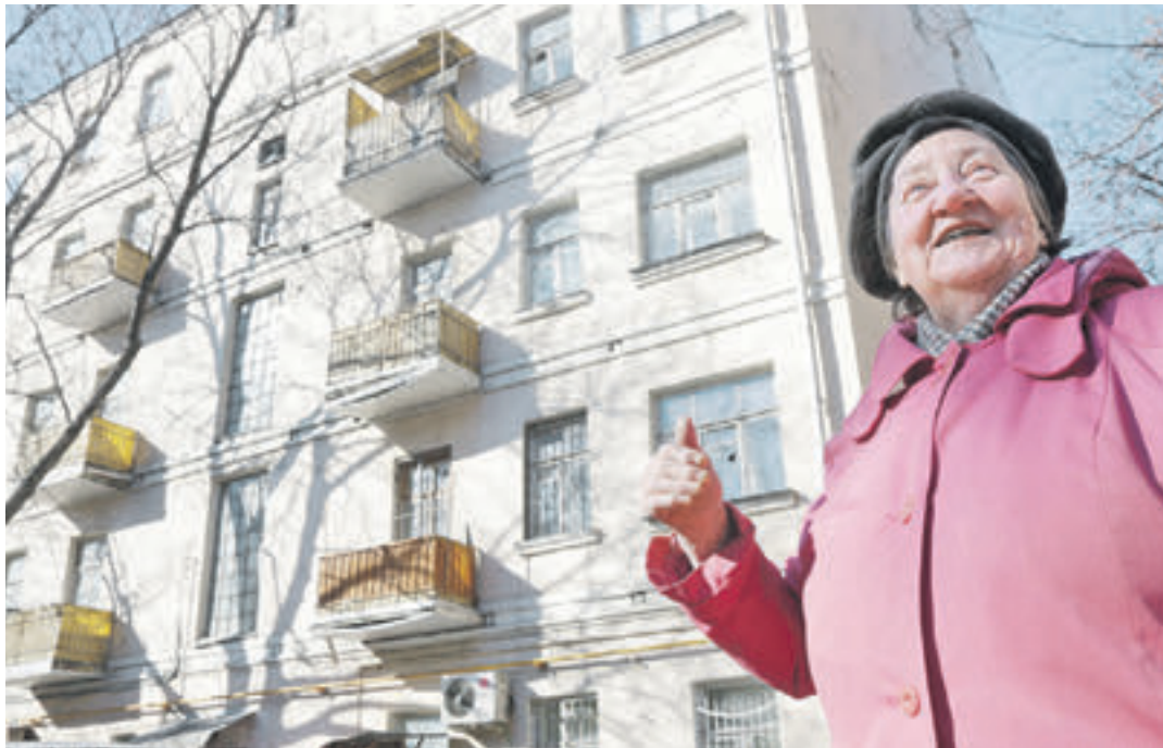
23 марта 2015 года, Нина Морозова, жительница одной из старых пятиэтажек по улице Нижняя Масловка, 11/13, построенных в середине XX века, указывает на обветшавший дом
