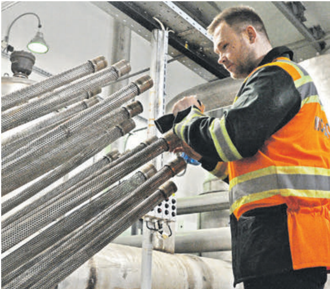
7 апреля 2017 года. Работа очистной станции на Краснопресненской набережной. Кирилл Русанов показывает, как работают фильтрующие установки
