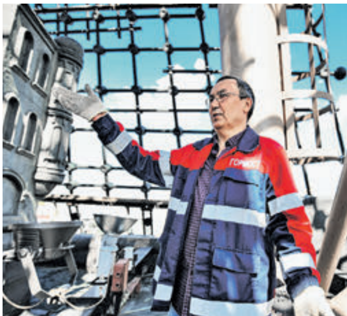
20 июля 2017 года. Главный специалист группы надзора ГБУ «Гормост» Салкарбек Шамканов осматривает конструкции мачты памятника
