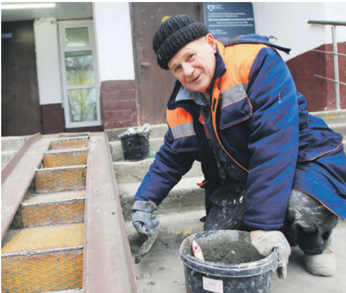
23 ноября 2017 года. Штукатур-маляр ГБУ «Жилищник Таганского района» Николай Макаров завершает установку пандуса-швеллера у третьего подъезда дома 4 по улице Рогожский Вал
