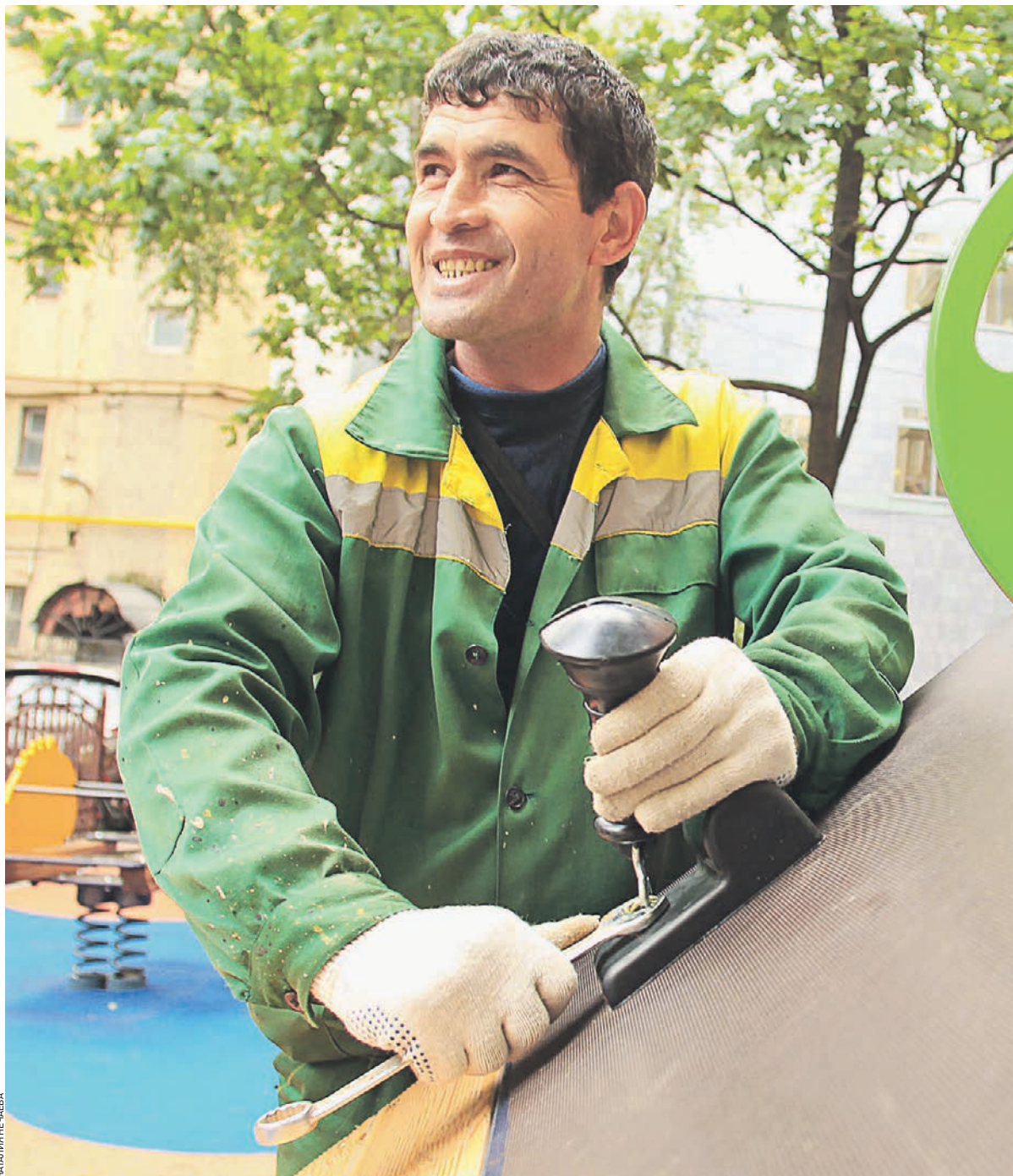
18 сентября 2017 года. Аббос Гадаев прикручивает зацепы для детского скалодрома на игровом комплексе, который установлен во дворе дома на Садовнической набережной
