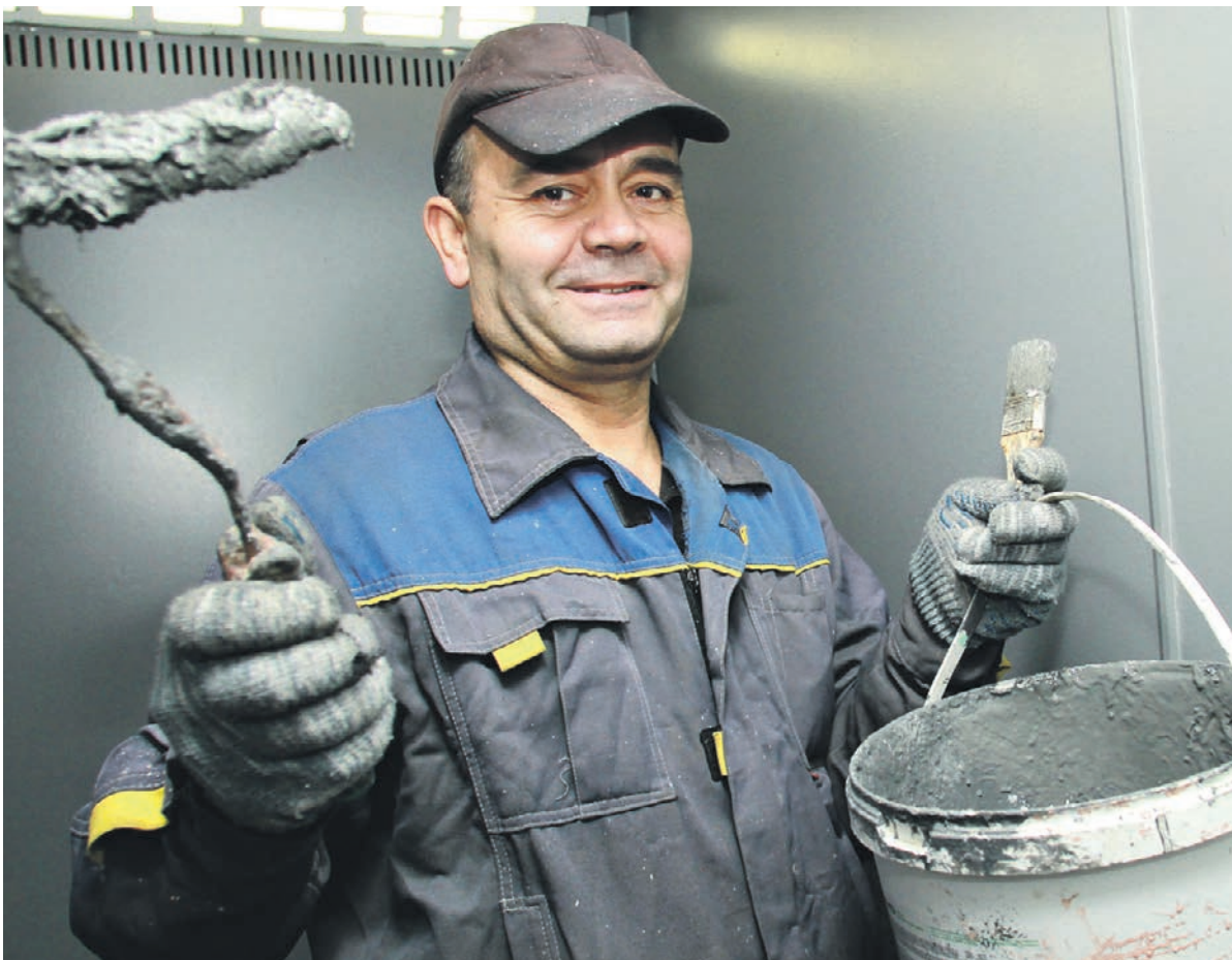
6 декабря 2018 года. Маляр эксплуатирующей организации дома № 2 в Волховском переулке Бахтияр Хамроев красит стены в кабине лифта. Проводить такие работы ему приходится регулярно
