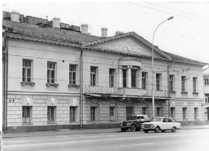
Дом Долговых, построенный в 1770 году, ждет комплексная реставрация. Так он выглядел в 1983 году
