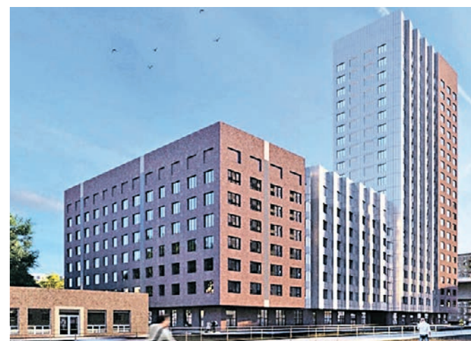
По проекту здание облицуют панелями с имитацией кирпичной кладки и матовыми белыми кассетами. Около дома обустроят прогулочную зону
