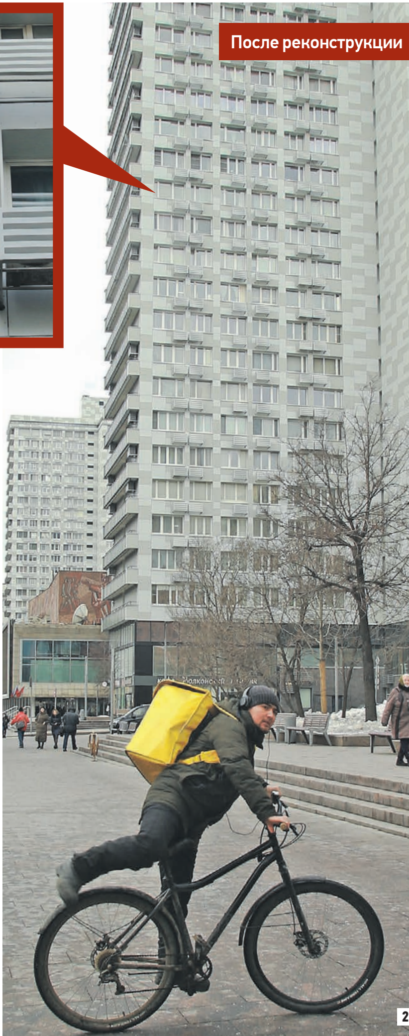
19 марта 2021 года. Дома-книжки на улице Новый Арбат «обтянули» фиброцементными плитами, которые хорошо сохраняют тепло и пропускают меньше шума (2). 2014 год. Фасад здания до ремонта (1)
