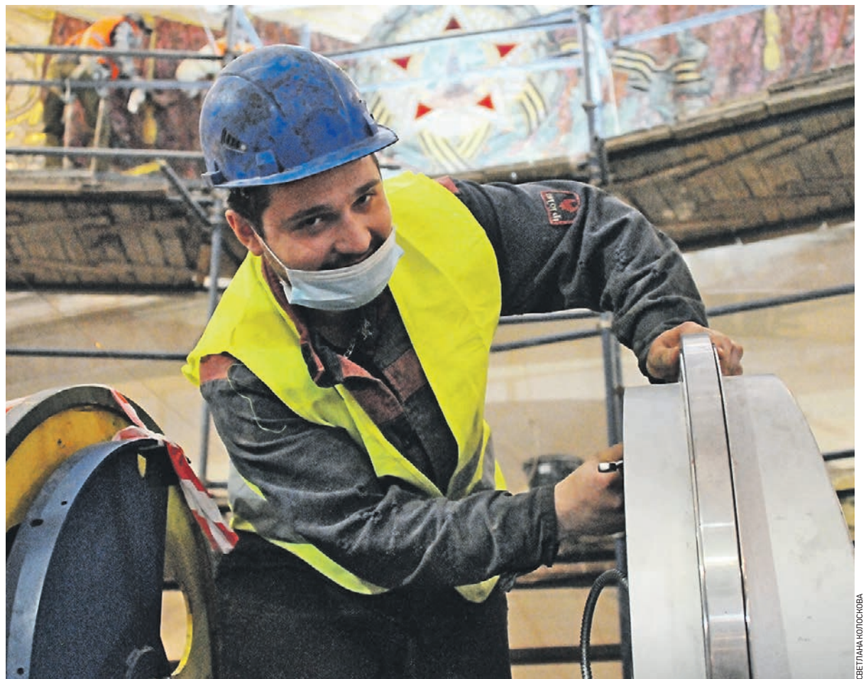
6 мая 2021 года. Электросварщик Виктор Воргунев проводит работы по установке нового эскалаторного комплекса на станции метро «Смоленская». Новые подъемники будут безопаснее и удобнее для пассажиров
