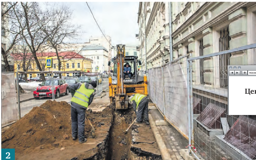
Проект благоустройства одного из переулков Арбата (1). 5 марта 2022 года. В рамках первого этапа благоустройства рабочие ведут подготовку к прокладке кабельной и ливневой канализации, а также устройству закладных деталей под опоры освещения (2)
