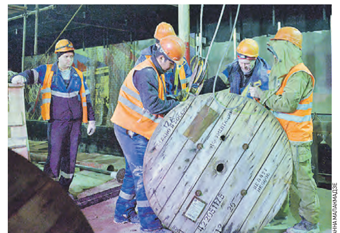
12 апреля 2022 года. Строители проводят монтаж инженерных систем на станции «Сокольники» Большой кольцевой линии
