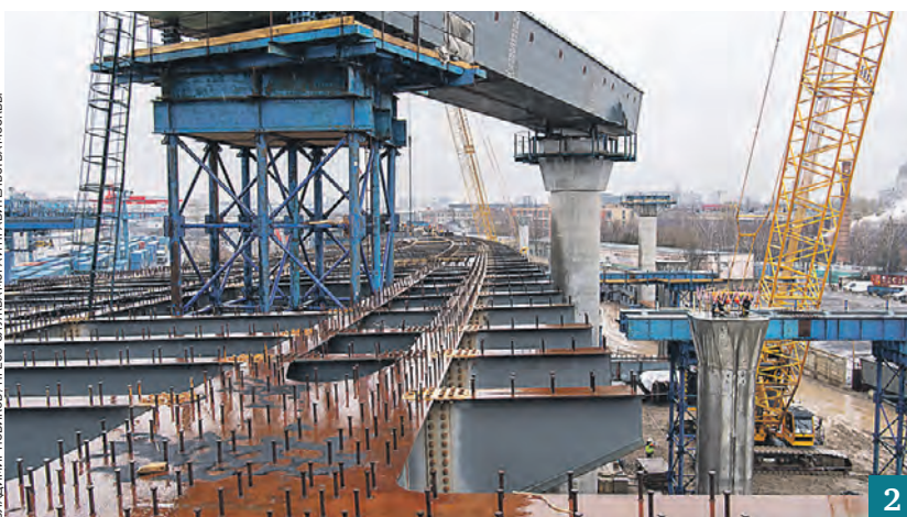
11 апреля 2022 года. Мэр Москвы Сергей Собянин беседовал с генеральным директором компании-инвестора Денисом Яневым (1) в ходе осмотра строительства Северного дублера Кутузовского проспекта (2)
