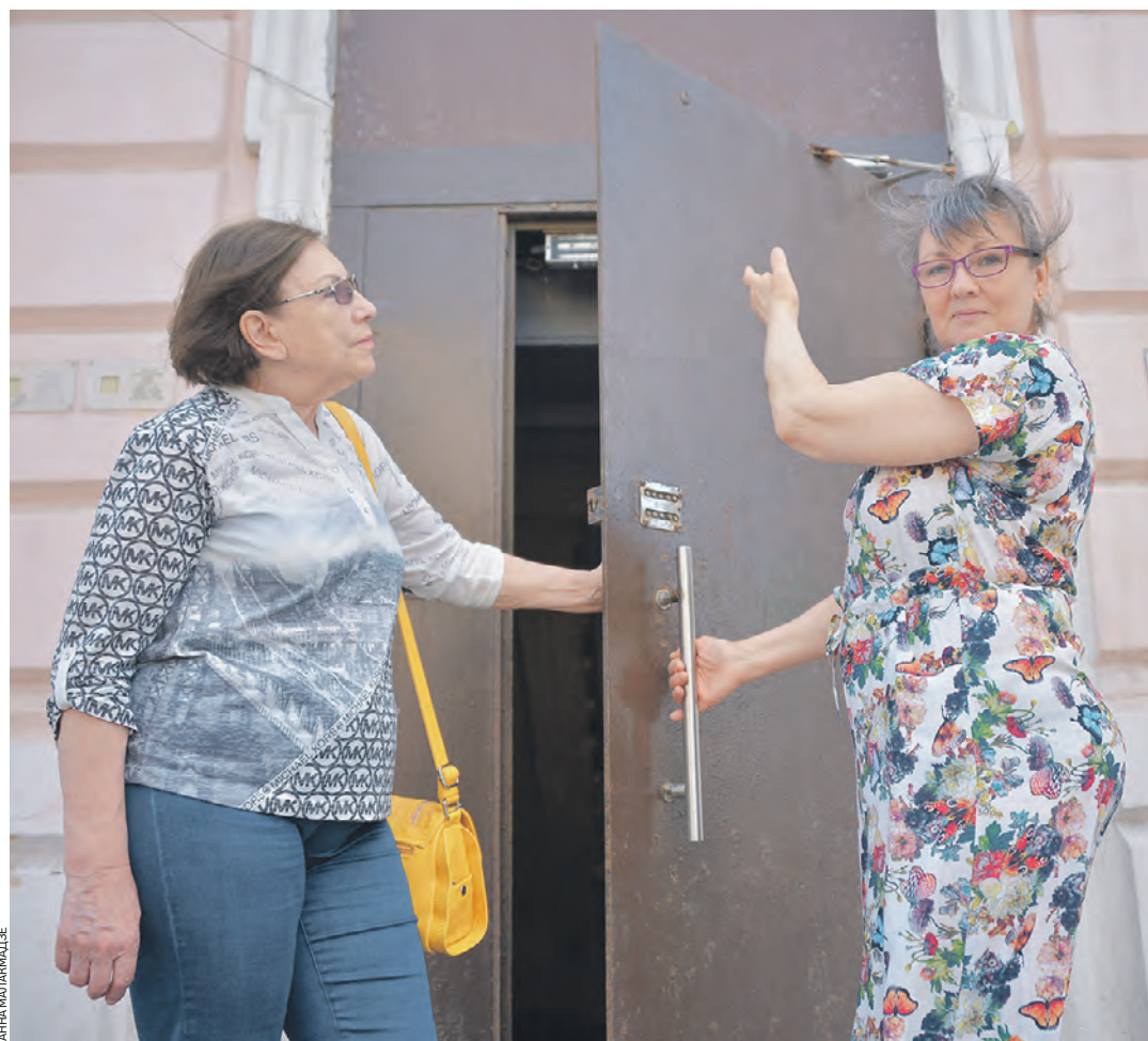
10 июня 2022 года. Жильцы дома № 17 по Смоленскому бульвару Татьяна Самойлова (слева) и Татьяна Школьникова проверяют на прочность входную дверь в подъезд, которая до ремонта буквально «вываливалась»
