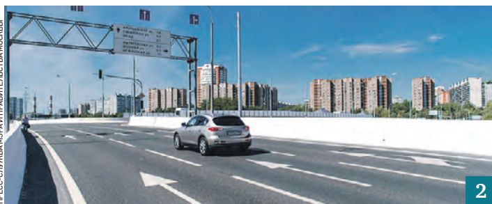
16 августа 2022 года. Управляющий проектом строительства Виктор Коротин (слева) пообщался с мэром Москвы Сергеем Собяниным (в центре) на открытии путепровода (1). Новая магистраль проходит через пути Киевского направления Московской железной дороги (2)
