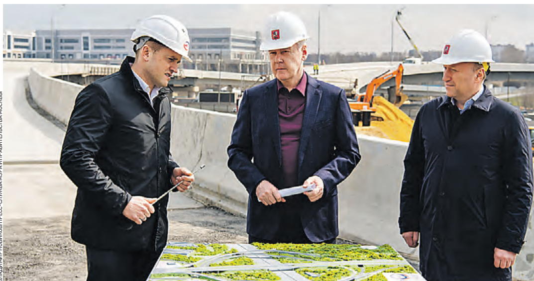
10 апреля 2023 года. Мэр Москвы Сергей Собянин общается с представителем компании-подрядчика Алексеем Козловым (слева) и заммэра по вопросам градполитики и строительства Андреем Бочкаревым (справа) во время осмотра хода реконструкции развязки на пересечении МКАД с Липецкой улицей
