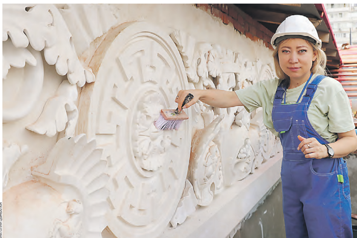
28 июля 2022 года. Мастер участка Айнагуль Алимкулова чистит смонтированные восстановленные элементы фасада во время реставрации учебного корпуса МГТУ им. Баумана
