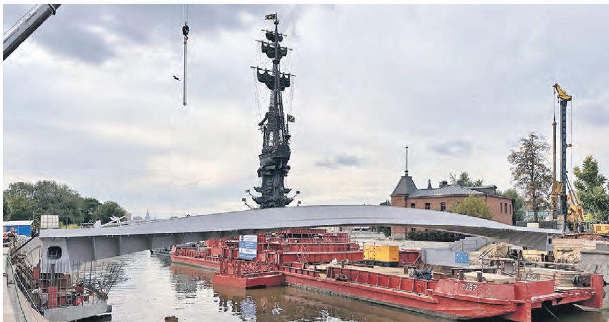
15 сентября 2023 года. Завершена установка пролета моста между островом Балчуг и парком искусств «Музеон». Мост был собран около Лыткарина и доставлен в нужное место на барже. Полностью завершить работу планируют к 2025 году
