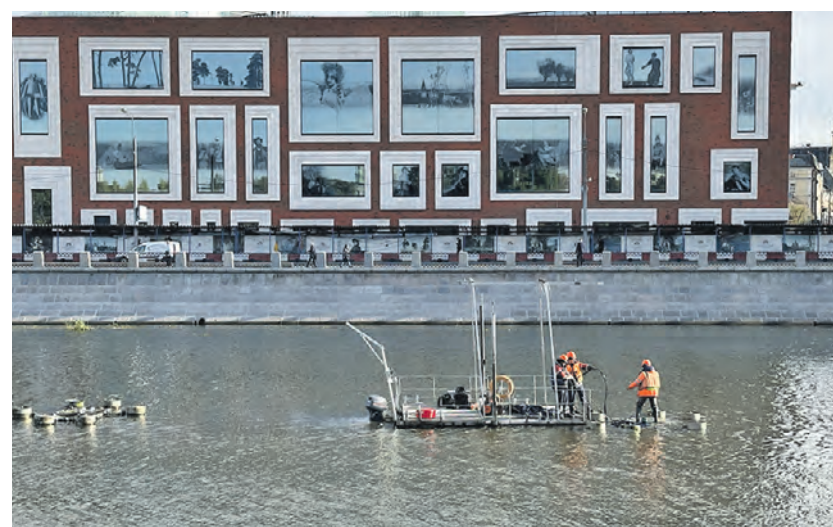
Консервация фонтанов на Водоотводном канале
