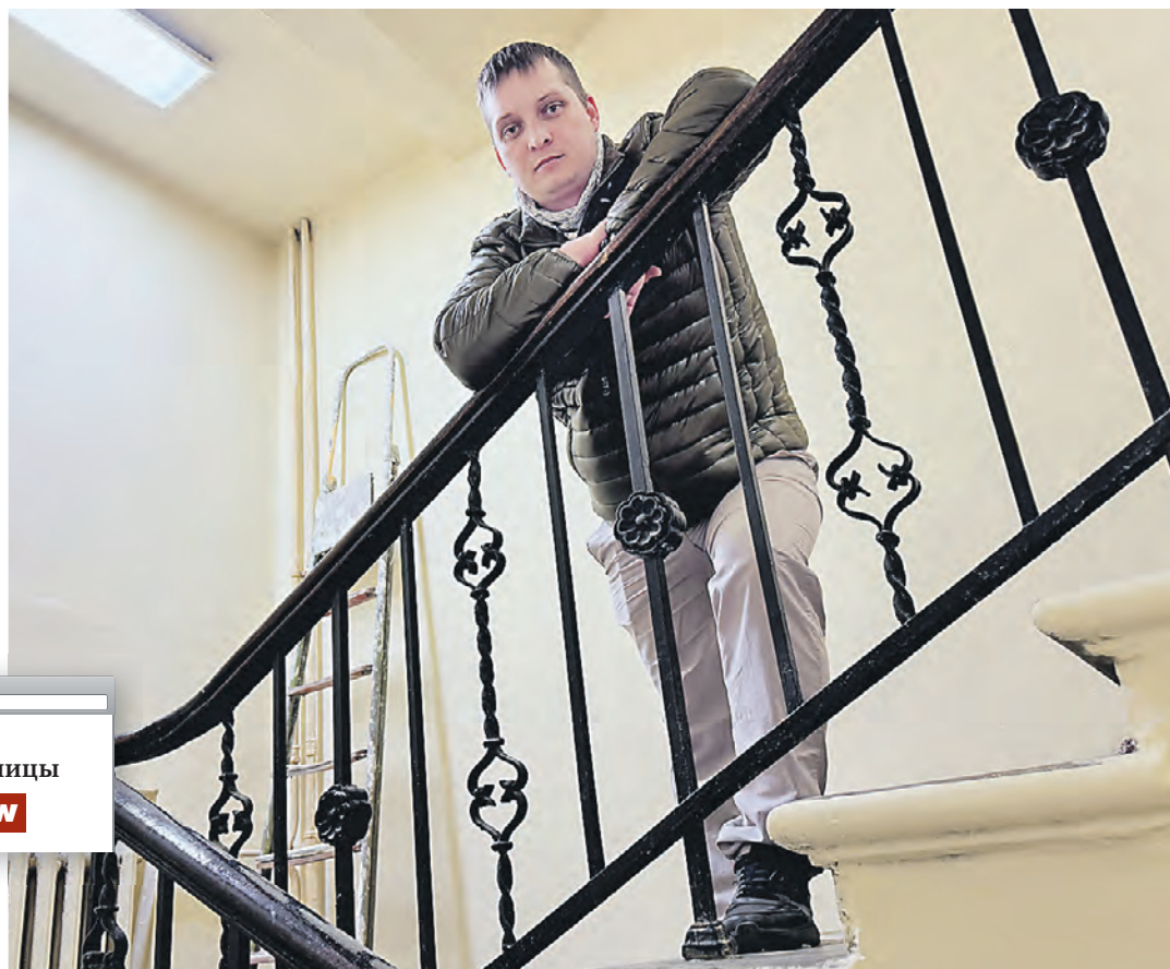
5 апреля. Главный инженер ГБУ «Жилищник района Арбат» Александр Никифоров показал, что последствия протечек убрали и в подъезде, и в подвале. Фото: Анна Малакмадзе
