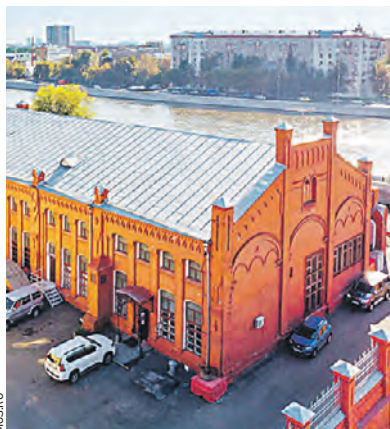
Здание Главной насосной станции на Крутицкой набережной
