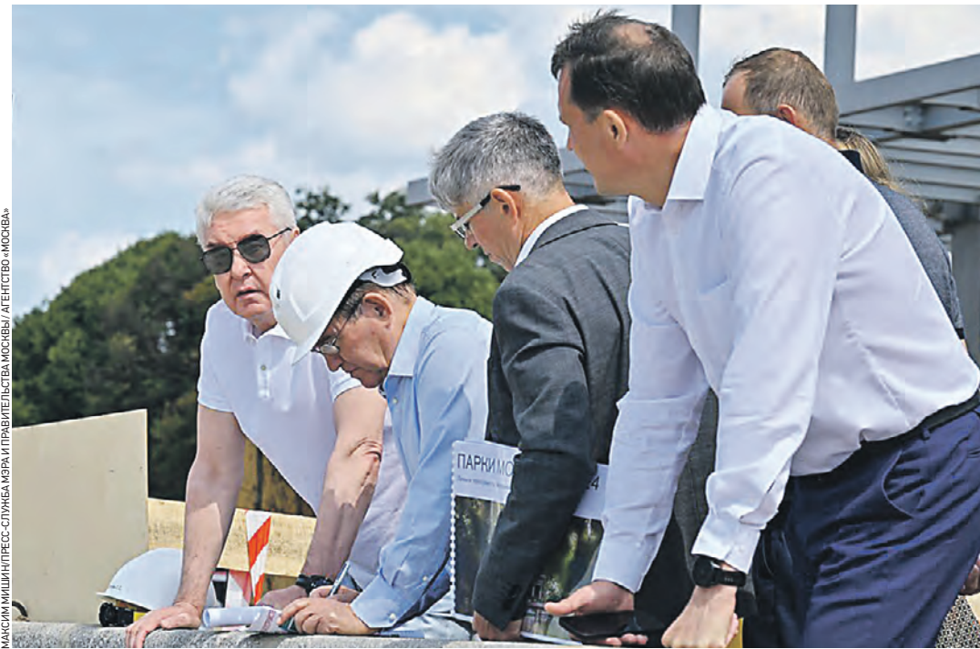
10 июля. Мэр Москвы Сергей Собянин, заммэра Москвы по вопросам ЖКХ и благоустройства Петр Бирюков, руководитель Департамента культуры столицы Алексей Фурсин, префект ЦАО Владимир Говердовский (слева направо) осматривают ход работ по благоустройству
