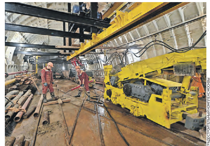
15 июля. Началось строительство станции «Достоевская» Кольцевой линии Московского метрополитена
