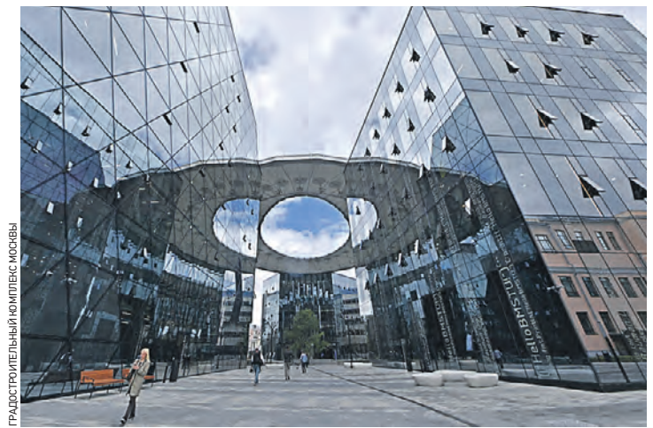
Работы по строительству новых корпусов практически завершены. Студенты придут сюда уже в сентябре
