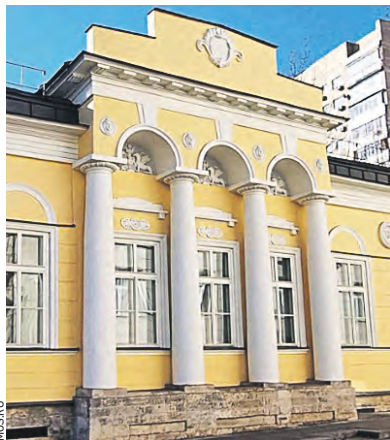
Так выглядит обновленный фасад особняка А. В. Лопатиной
