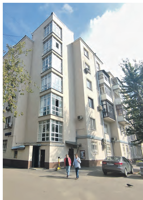
Дом № 2/5 в Орлово-Давыдовском только что отремонтирован. Фото: Мария Хапцова
