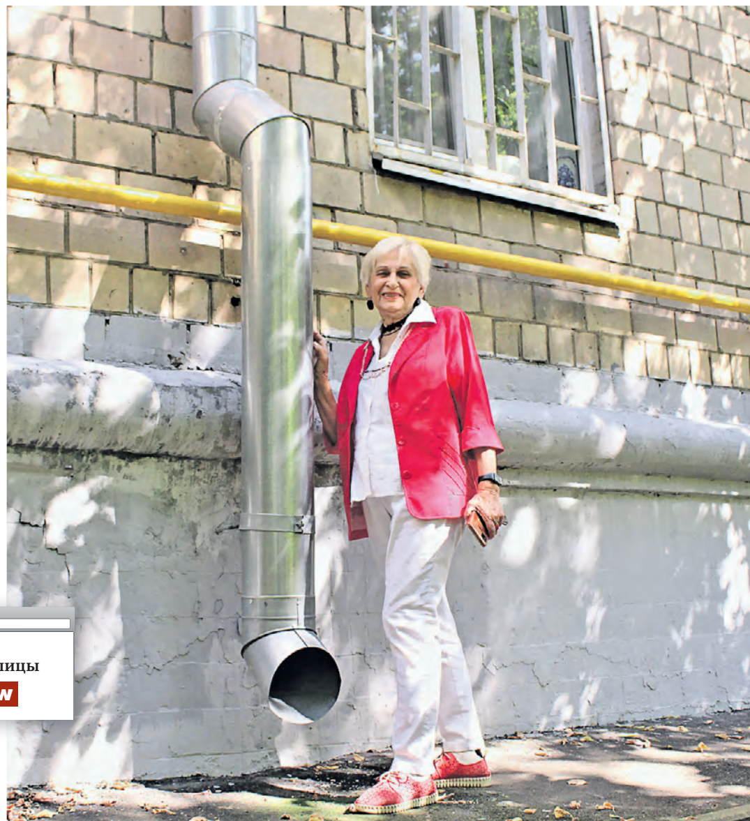
5 сентября. Алла Чуваева показала обновленную водосточную трубу. Фото: Мария Хапцова
