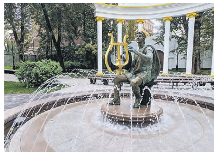
В фонтане отремонтировали систему подачи воды, заменили трубы и насосы, почистили фигуру древнегреческого бога Аполлона
