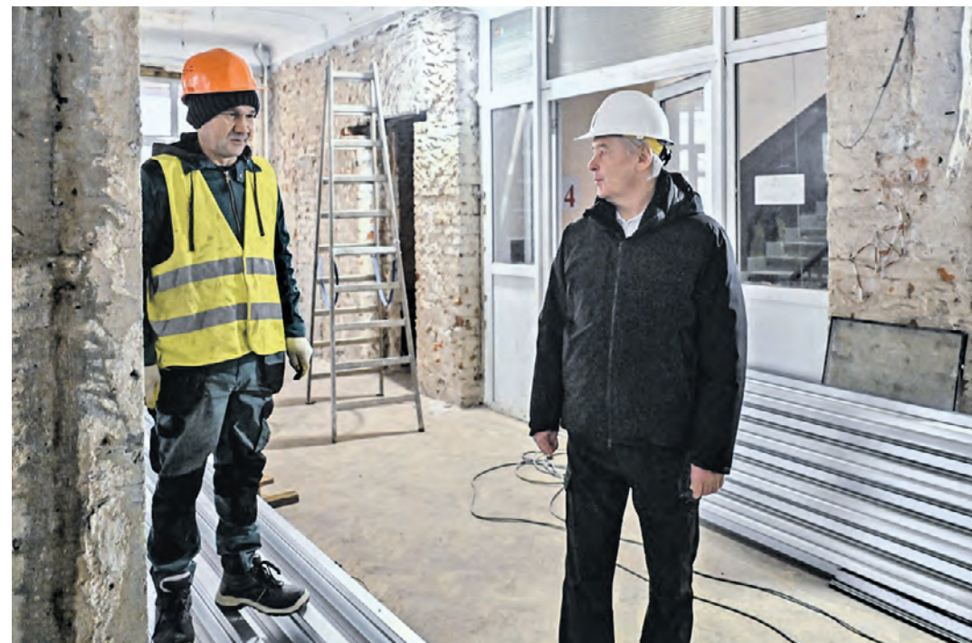
5 ноября. Мэр Москвы Сергей Собянин осмотрел реконструкцию здания школы № 1501 в Тверском районе
